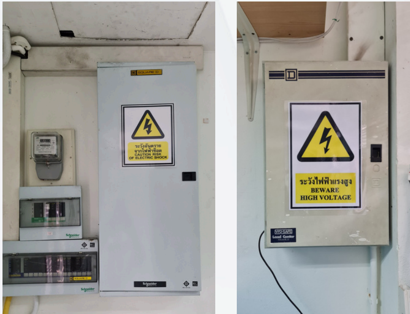
รูปที่ ๒.๑๒ แสดงตู้เบรกเกอร์หลักและย่อยในอาคารศูนย์วิจัย
