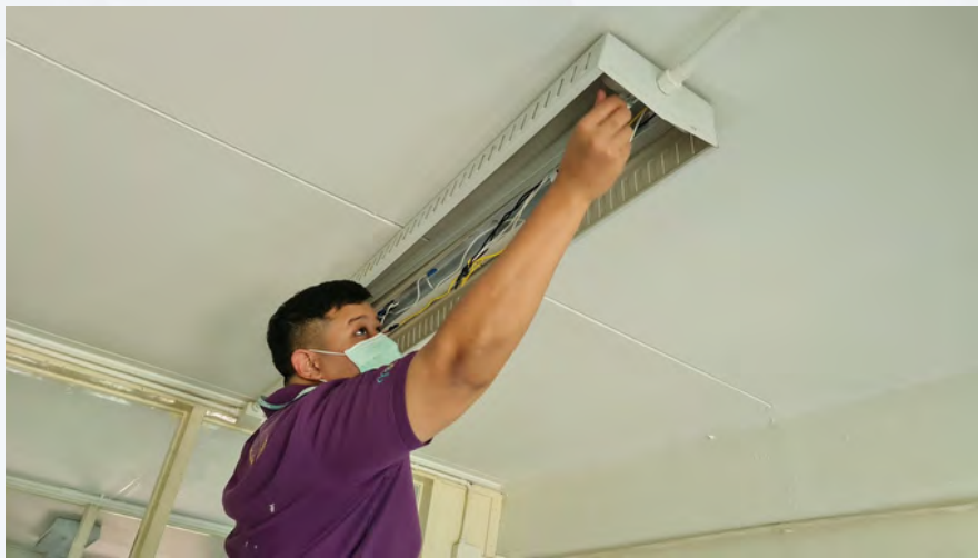
รูปที่ ๒.๙.๑.๓ มีการแก้ไขระบบไฟในห้องพักอาจารย์ของสถาบันฯ โดยคกก.ระบบกายภาพ
