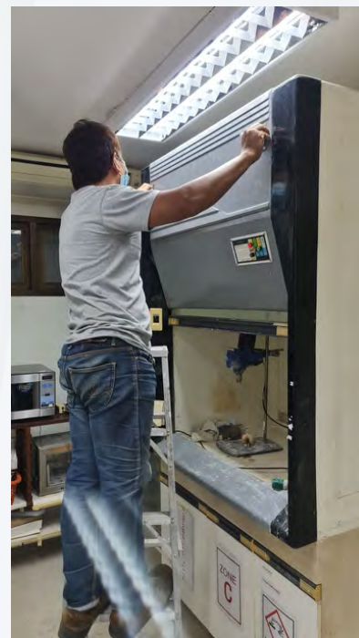
รูปที่ ๒.๙.๑.๔ ประสานงานช่างมาทำการแก้ไขระบบไฟของตู้ดูดควันในห้องปฏิบัติการวิจัย
