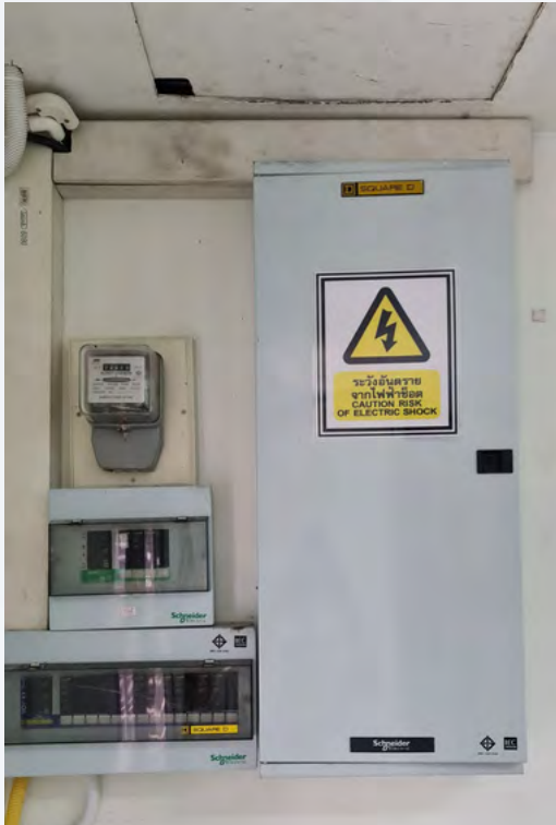
รูปที่ ๒.๑๒ แสดงตู้เบรกเกอร์หลักและย่อยในอาคารศูนย์วิจัย
